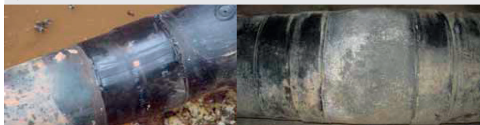
sigillatura in campo
